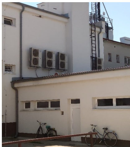
Kaskáda tepelných čerpadiel 4 x 16kW Panasonic T-CAP
