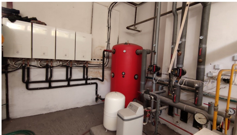
Kaskáda tepelných čerpadiel 4 x 16kW Panasonic T-CAP
